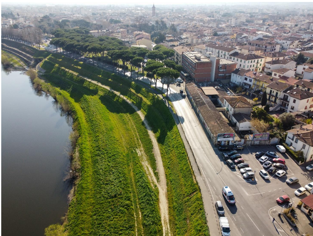
fig. 1 – immagine aerea del complesso, con evidenziato il ruolo di “cerniera” tra l’Arno e la città storica
