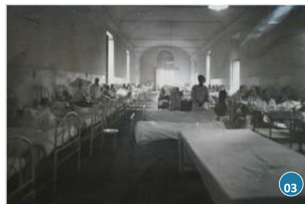
Ripristino dell'ambiente originario, unica testimonianza recuperabile dell'assetto ottocentesco dell'Ospedale, attraverso la demolizione delle tramezzature e del controsoffitto esistente; il ripristino riguarda anche le facciate esterne, con la riapertura dei finestroni laterali (e il tamponamento delle finestre realizzate nel dopoguerra in contrasto con la partitura geometrica dei prospetti).
