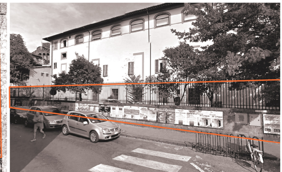
Segmento di mura e recinzione del complesso di San Giuseppe oggetto di demolizione
