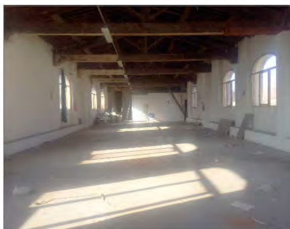
FOTO 3 Vista della copertura in legno, da recuperare e rivestire con uno strato isolante esterno
