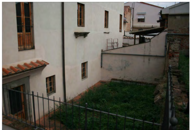
Vista dei terrazzi lungo il percorso delle mura – complesso degli Agostiniani
