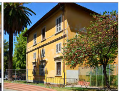
FOTO 2 Vista dell'angolo dall'edificio tra il giardino di Largo della Resistenza
