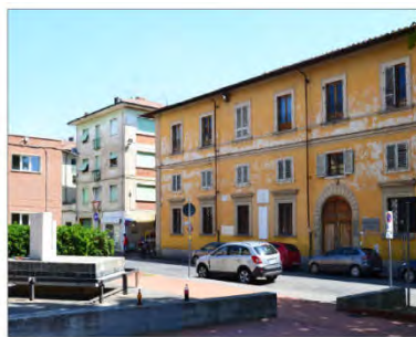
FOTO 1 Vista dell'edificio oggetto di recupero
