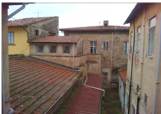
FOTO 2 Gli interventi sull'involucro edilizio saranno un'occasione per dare uniformità architettonica ai singoli edifici del Complesso, in larga parte disomogenei e privi di relazioni con il contesto storico
